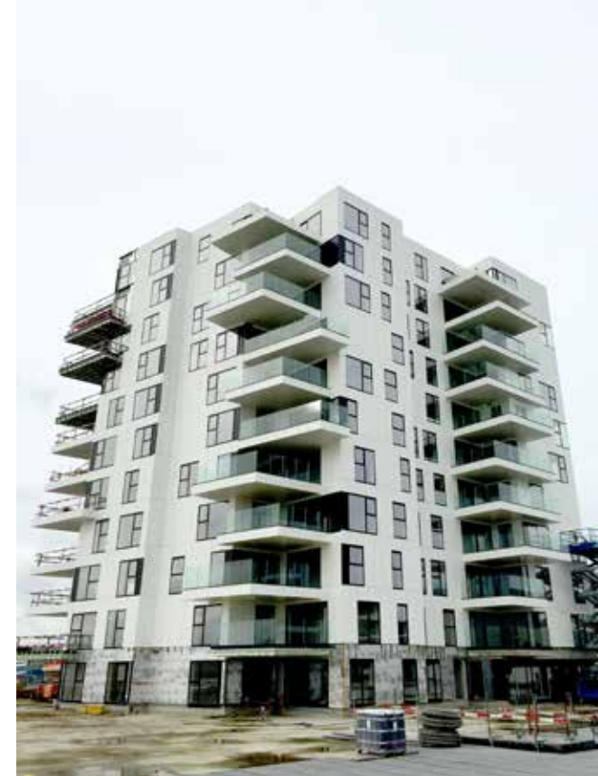
Aleca in aanbouw, de vijfde toren op de voormalige Boelwerf langs de Schelde in Temse.
