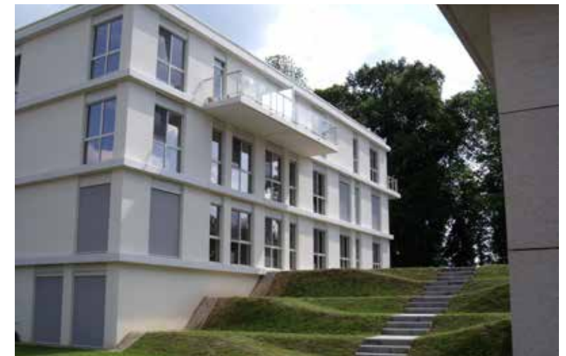
De eerste fase van het woonzorgcentrum omvat het optrekken van drie gebouwen rond een binnenplein.
