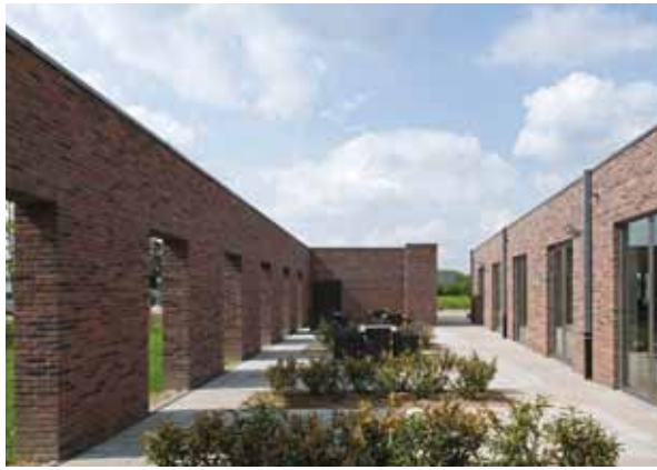
Woonzorgcentrum Ravenstein, Boortmeerbeek (B)
